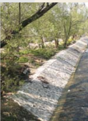
Diguri râul Ieudișor, mal stâng
