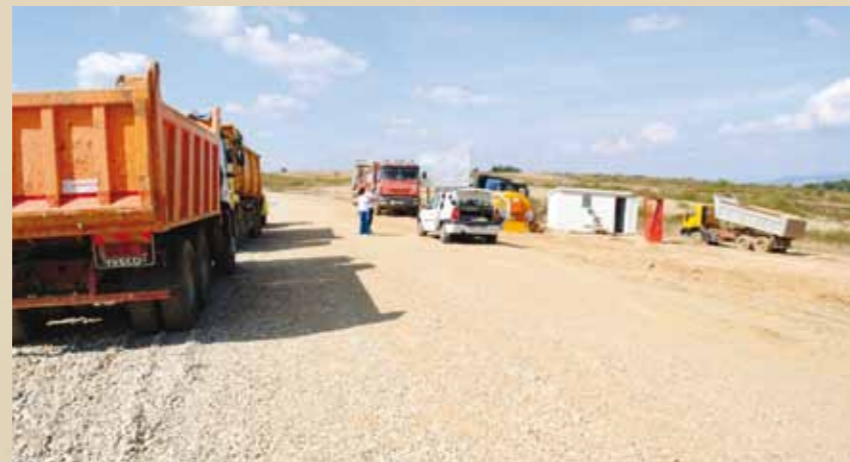
Lucrări la Depozitul ecologic de la Sârbi, comuna Fărcașa, septembrie 2015 (2)
