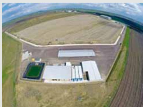
Depozit Ecologic moara Suceava
