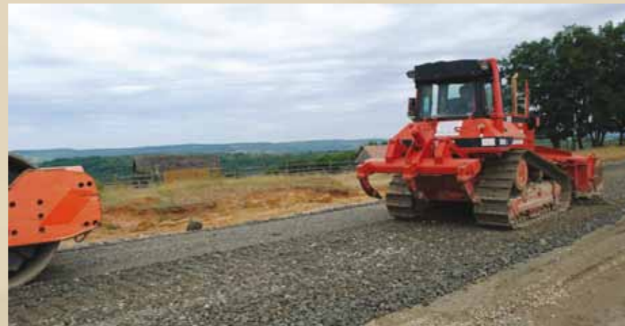
Lucrări la Depozitul ecologic de la Sârbi, comuna Fărcașa, septembrie 2015 (2)
