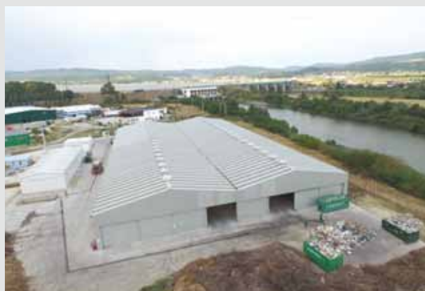
Depozitul ecologic RAMNICU VÂLCEA
