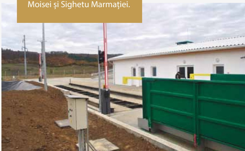
Stație de transfer a deșeurilor la Târgu Lăpuș
