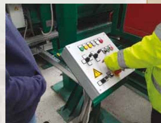
Panou de comandă general - Stația de Sortare Sighetu Marmăției și Panou comandă presă - Stația de Transfer Sighetu Marmăției
